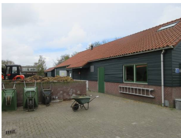
Mestopslag (t.p.v gebouw 5)
