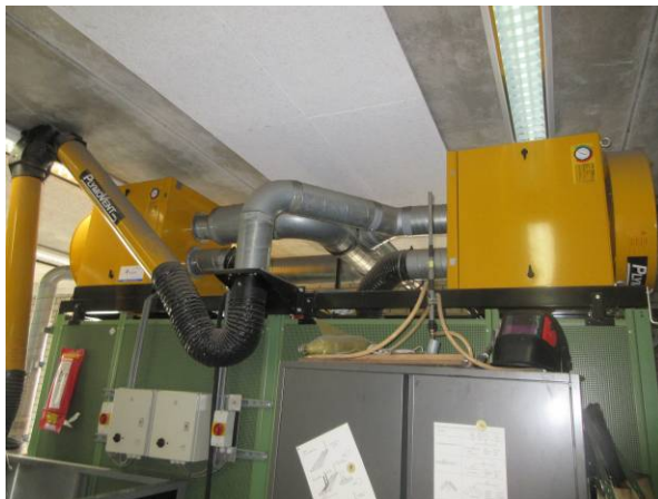
Afzuiging (praktijklokaal gebouw 1)
